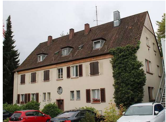
Außenfassade + Dachstuhl „Bürgermeisterhaus“
